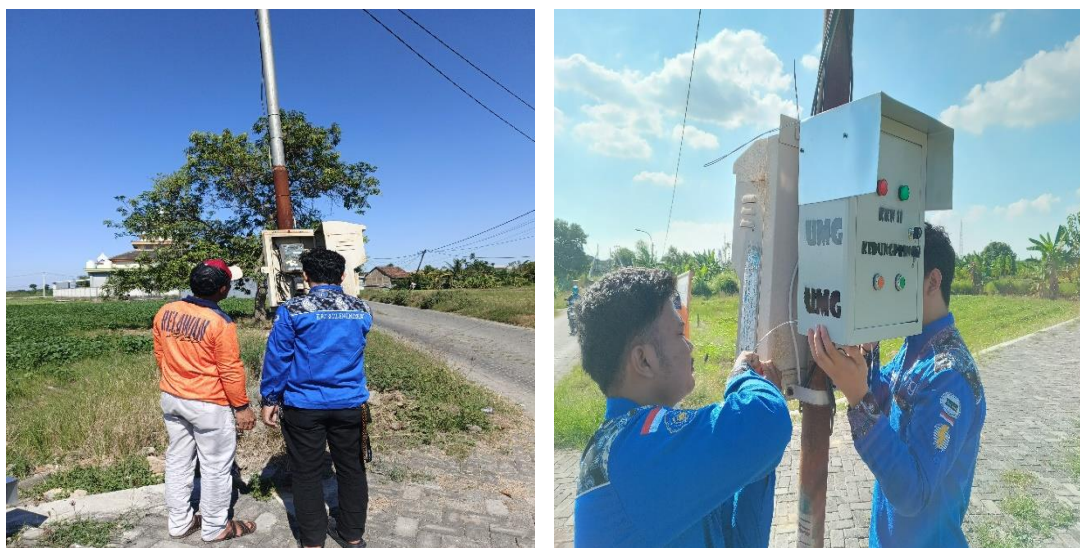
Gambar 9. Pemasangan PJU Desa Kedungpring
